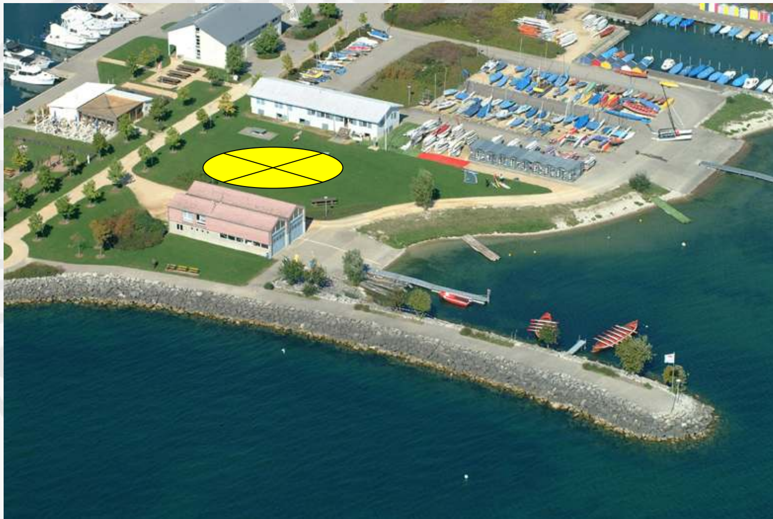
Vue générale du site : Zone des soins
